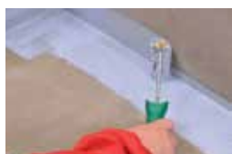
3 / Henger segítségével nyomja bele a Tömítőszalagot a függőleges és vízszintes sarkakba.
