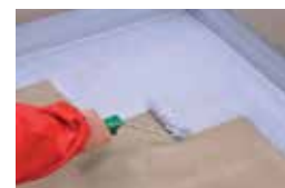
6 / Mérje le a megfelelő hosszúságú szalagot, és illessze a vízszigetelő bevonatba.
