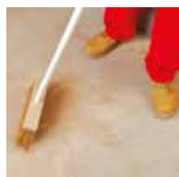
1 / Tisztítsa meg az aljzatot a portól és a szabad szemcséktől.
