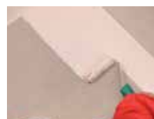
7 / Lehetőleg az első rétegre merőlegesen hordja fel a bevonóanyagot
