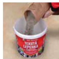
5 / Szórja bele a porszerű komponenst a folyékonyba.
