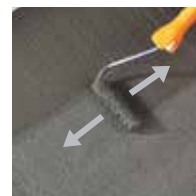
12 / Hordja fel a Folyékony vízszigetelés második rétegét.
