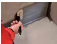
2 / Alapozza le az aljzatot, és egyenlítse ki a nedvzivó képességét
